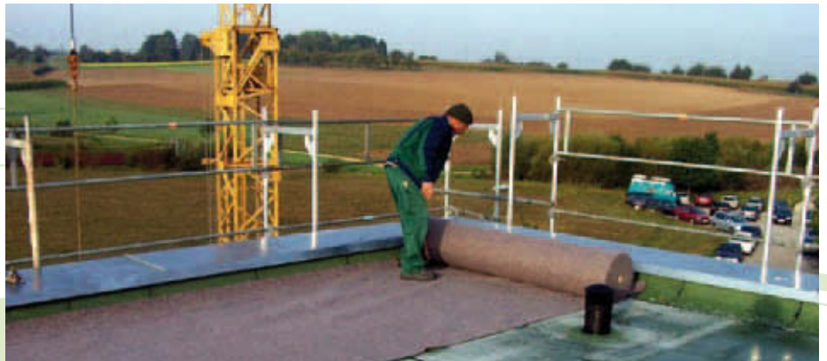
ZinCo-Schutzmatten bieten mechanischen Schutz und speichern zudem Feuchtigkeit.
