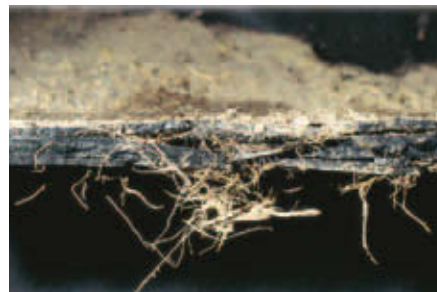
Eine von Wurzeln durchdrungene Bitumenabdichtung ohne Wurzelschutzausrüstung.
