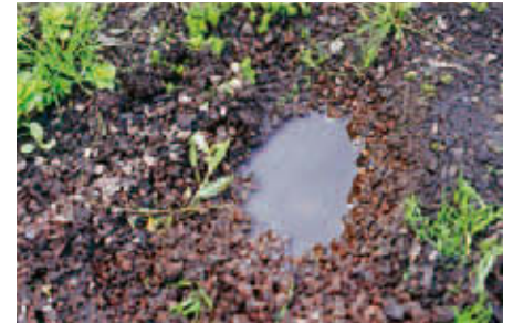
Die Dränfunktion dieser „Dachbegrünung“ ist offensichtlich unzureichend...
