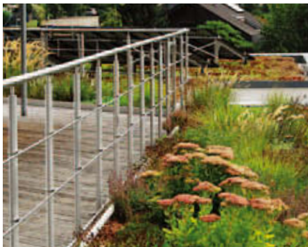
ZinCo Geländelösungen – attraktiv, funktional und auf dem Dach befestigt, ohne Durchdringung der Dachhaut!
