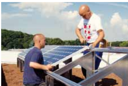
5. Die Solarmodule werden montiert.
