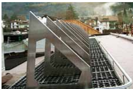
Rahmen 45° für Solar-Thermie auf 5° geneigter Dachfläche.
