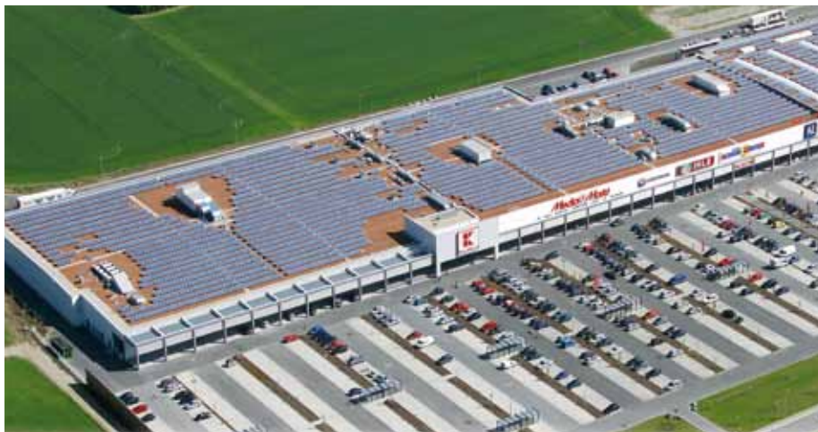
Photovoltaik-Anlage auf dem InCenter in Landsberg/Lech nach der Fertigstellung
