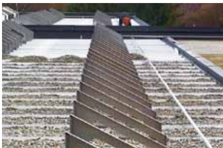
Kopplung der Anlage mit Aluprofilen bei einem Standort mit Windzone 2 und Zuschlag „Küste“.
