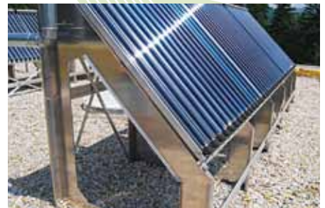
Grundrahmen in verändertem Winkel kommen oft bei Thermieanlagen zum Einsatz.
