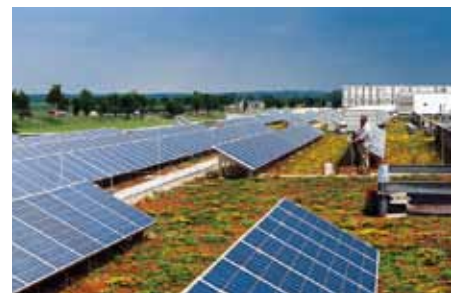
6. Das fertig begrünte Dach mit Solaranlage.
