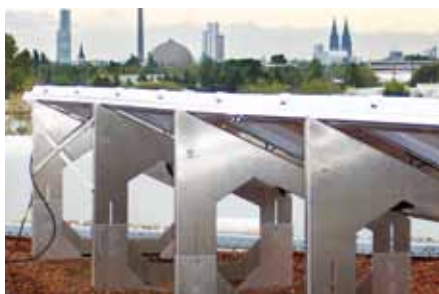
Höhenverstellbare Rahmen z.B. zum Ausgleichen von Dachgefälle.
