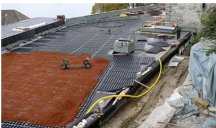
Das Drän- und Wasserspeicherelement Floradrain® FD 60 stellt sicher, dass die Entwässerung des Daches über die beiden Schmalseiten funktioniert.
