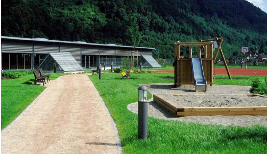
Die Haupt-Dachfläche nach der Fertigstellung im Juli 2002.
