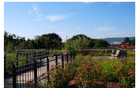
Die Pfosten des Geländers wurden ohne Dachdurchdringung auf der ZinCo Geländerbasis GB montiert.
