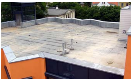
Das wurzelfest abgedichtete Dach vor Beginn der Begrünungsarbeiten.
