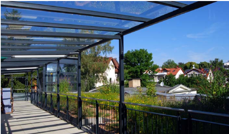
Einer der beiden attraktiv gestalteten Dachgärten ist auch bei Regen nutzbar.
