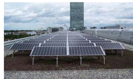
Die Solarpanels wurden bis fast an den Dachrand gebaut um die gesamte Fläche bestmöglich auszunutzen.
