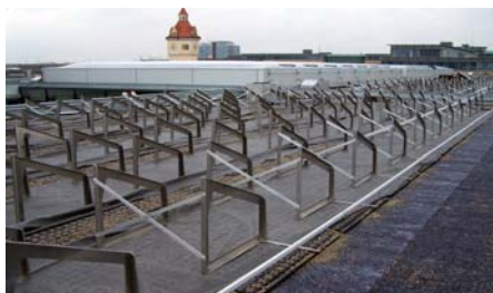
Die Solargrundrahmen wurden auf jeweils 2 m 2 großen ZinCo Solarbasisplatten SB 200 montiert.
