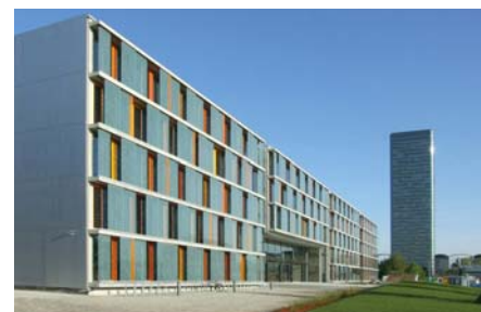
Die Außenansicht des Münchner Technologie Zentrums.
