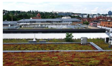
Die verschiedenen Ebenen wurden mit einer extensiven Begrünung versehen.
