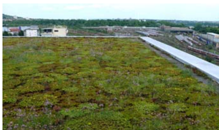
Die Sedumpflanzen wurden als Sprossen aufgebracht; längst bilden Sie einen dichten Teppich.
