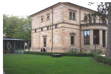
Selbst unter der Rasenfläche befindet sich der Systemaufbau mit Fixodrive® FX 50.
