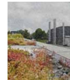
Bei Starkregenereignissen mit z. T. 100 Liter/qm in wenigen Stunden kommt jede Kanalisation an oder über ihre Grenzen. Der Systemaufbau Retentions-Gründach hält kurzfristig eine große Menge Niederschlag zurück und gibt diesen gedrosselt an die Kanalisation ab.
