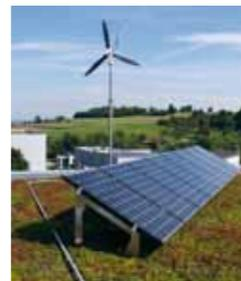
Wir zeigen Ihnen, wie Sie Absturzsicherungen und Solaranlagen auf dem Dach befestigen, ohne die Dachabdichtung durchdringen. Das Spektrum reicht dabei vom Arbeitsschutz durch Einzelanschlagpunkte oder Schienensystemlösungen bis zum Systemgeländer. Auch Solaranlagen lassen sich durchdringungsfrei auf dem Dach montieren, außerdem bewirkt die Kombination mit Dachbegrünung messbare Synergie-Effekte!
