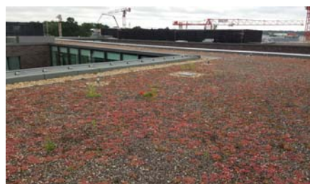
Unterschiedliche Sedumarten wurden als Sprossensansaart auf der ca. 3.800 m 2 großen Dachflächen ausgebracht.
