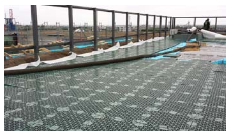
Die Spacer ermöglichen gezielte Wasserspeicherung auf dem Dach und zeitverzögerten Abfluss. Das entlastet die Kanalisation enorm.
