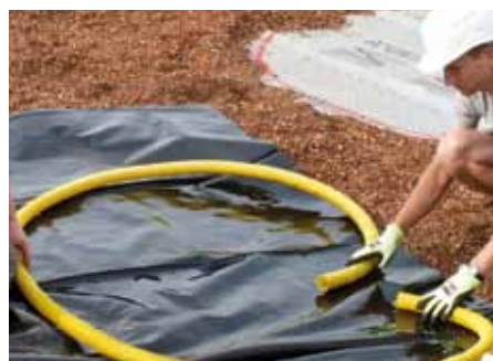
Mit Dränschläuchen und Folien entstehen temporäre Wasserflächen.
