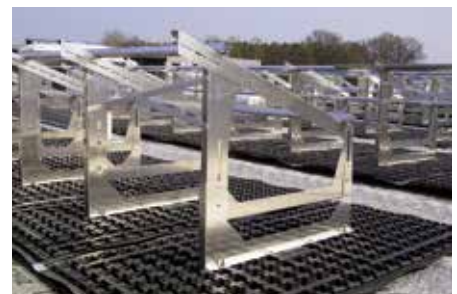
Höhenverstellbare Rahmen und Adapterprofile ermöglichen den Ausgleich von Dachgefälle und die Montage von größeren Modulen.
