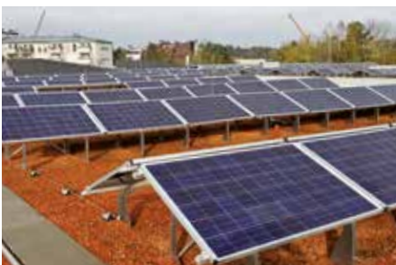
Solaraufständerung Ost-West, hier in Variante „Sattel“.
