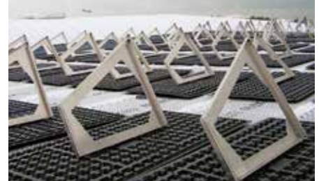
3. Auf den Solarbasisplatten werden die Solar-Grundrahmen platziert und ausgerichtet.
