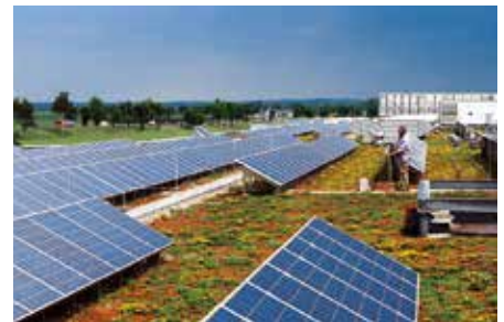
6. Das fertig begrünte Dach mit Solaranlage.
