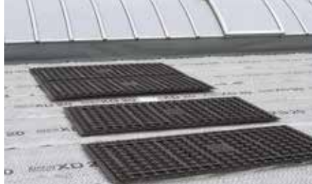
2. Anschließend werden die Solarbasisplatten ausgelegt.
