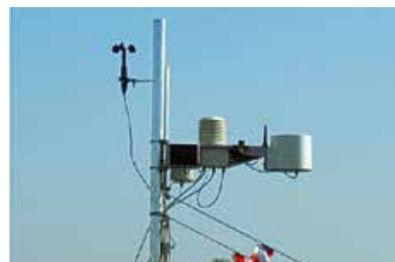
Über das gesamte Jahr hinweg wurden durchschnittliche Tagestemperatur-Differenzen von ca. 8 K gemessen.
