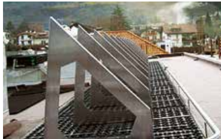
Rahmen 45° für Solar-Thermie auf 5° geneigter Dachfläche.
