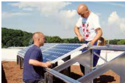
5. Die Solarmodule werden montiert.
