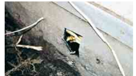
Bereits durch die Abdichtung gewachsene Bambusrhizome
