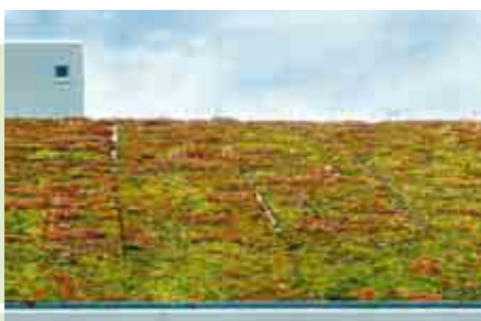
Fugen bei Vegetationsmatten
