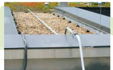
Durch ein S-förmiges Schienelement kann ein Höhenversprung elegant bewältigt werden, da der Läufer ohne Unterbrechung weiter gleiten kann.
