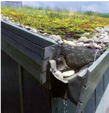
Abflussverzögerung einer extensiven Dachbegrünung.
