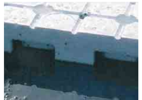
Die Lösung: ausreichend hohe Drainage mit Kapillarbruch.
