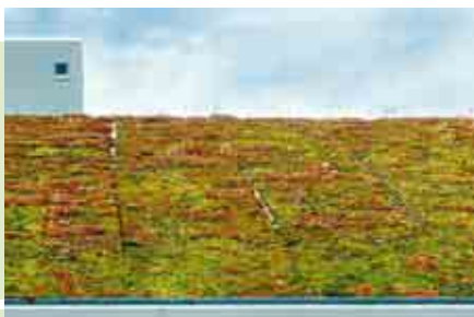
Fugen bei Vegetationsmatten
