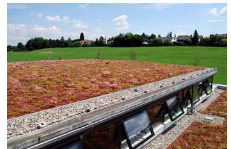
Flächendeckend und schön blühend zeigt sich das Dach bereits in der zweiten Vegetationsperiode.
