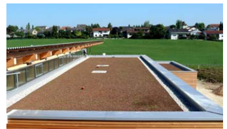
Blick auf ein fertiggestelltes, bereits mit Sedum-Sprossen bestücktes Dach.
