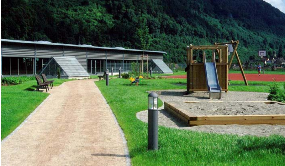
Die Haupt-Dachfläche nach der Fertigstellung im Juli 2002.
