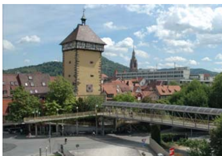
Vor der Sanierung versperrte die Fußgängerbrücke den Blick auf das historische Bauwerk.
