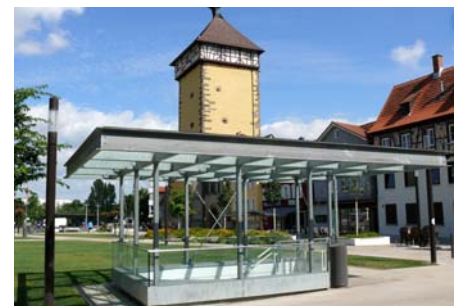
Der Treppenabgang zur Tiefgarage wurde ebenfalls modernisiert.
