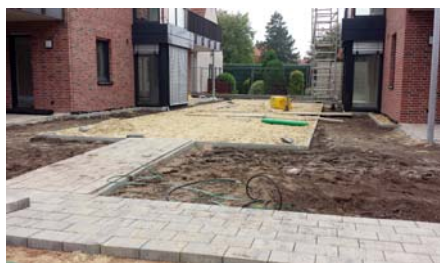
Ein Weg aus Pflastersteinen führt über die gesamte Tiefgarage.
