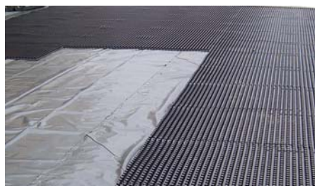
Zur gegenseitigen Fixierung wurden die PD 250-Platten nach der Verlegung miteinander verbunden.
