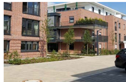
Die Geh- und Fahrbereiche wurden, wie auch die Pflanzbereiche, auf dem Dränelement Protectodrain® PD 250 realisiert.
