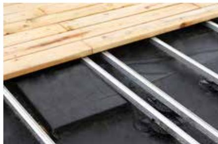
Eine weitere Variante ist der Einsatz unter flächig verlegten Holzbelägen. Mit den Stelzlagern lässt sich das jeweils gewünschte Gefälle einstellen.
