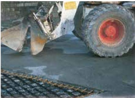
Auf Schottertragschichten (siehe vorige Seiten) bzw. auf der druckverteilenden Betontragplatte auf Floradrain® FD 60 neo ist der Einbau von Asphalttragschichten
