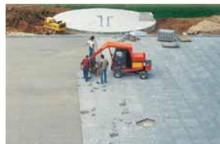
Der „Vor-Kopf-Einbau“ der Tragschicht und von den darüber liegenden Schichten ist auf Elastodrain® EL 202 selbst mit schwerstem Gerät möglich.
