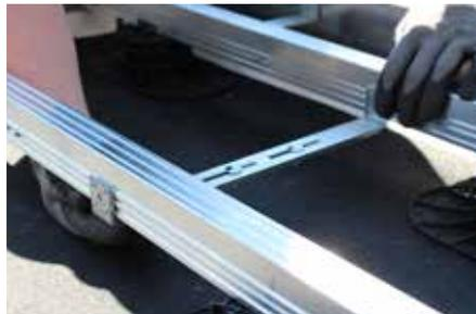
Der variable Abstandshalter passt sich jedem gewünschten Belagsformat an und sorgt für eine stabile Unterkonstruktion mit gleichbleibenden Maßen.
