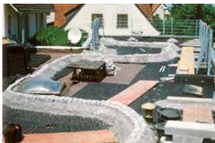
Die durchgängige Drainageebene ermöglicht die völlig freie Gestaltung der Linienführung.
