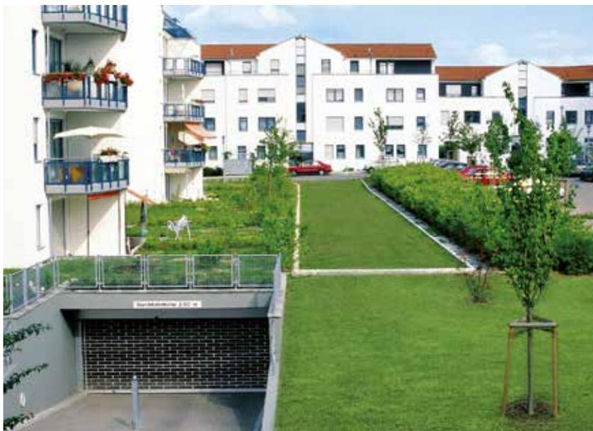
Aufgrund ihrer guten Erreichbarkeit und der meist hohen statischen Lastreserve bietet es sich auf Tiefgaragendecken an, einen Aufbau zu wählen, bei dem die Substrataufbringung mittels Radlader erfolgen kann.
