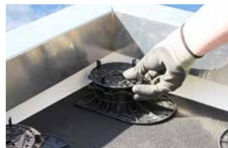
Bei diesem Bauvorhaben wurde die Plattenverlegung auf Elefeet® gewählt, um eine Einstaureserve bei sintflutartigen Regenfällen zu haben.
