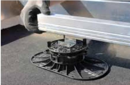
Der schnell fixierbare Schienen-Halteclip ermöglicht das praktische Einclippen der Schiene in der Kopfplatte der Elefeet® Stelzlager.
