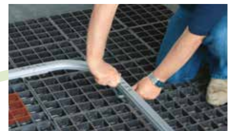
Das Fallnet® SR Rail wird mit einfachen Handgriffen ohne Spezialwerkzeug zusammengebaut. Schnell sind große Abschnitte durch Rasterelemente, Schienenhalter und die Schienen miteinander verbunden.
