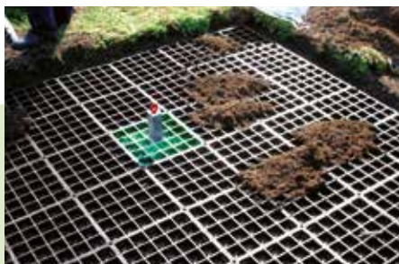
Beim Einbau ist grundsätzlich sicherzustellen, dass die erforderliche Auflast gegeben ist.
