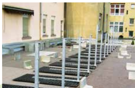
Nach Aufbringen einer Schutzlage über der Dachabdichtung werden die Geländerbasen GB/GB-Eck ausgerichtet und die Pfosten sowie ggf. die Halter für die Anschlagsschiene montiert.
