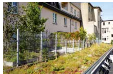
Nach dem abschließenden Montieren von Fallnet® SB 200-Rail steht den gesicherten Arbeiten im Bereich des Dachrandes nichts mehr im Wege.
