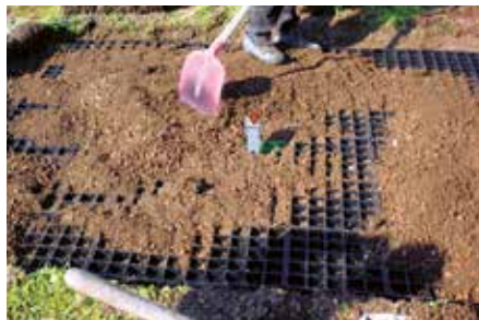
Die Rasterelemente des Fallnet® SR nehmen das Substrat durch die Wabenstruktur bestens auf.
