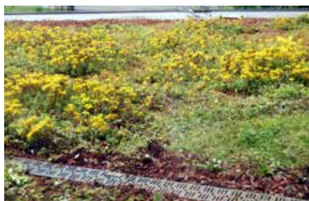
innenliegende Entwässerungsrinne
