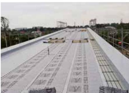
Grundlage ist der Systemaufbau „Steinrosenflur“, hier das Drainage-Element Fixodrain® XD 20.
