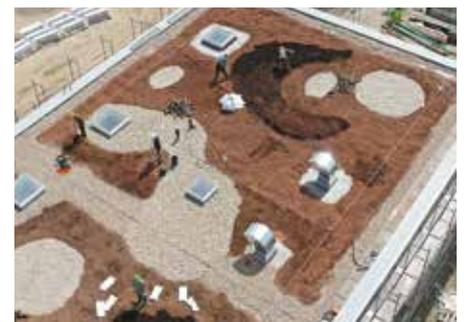
Sand-, Lehm- und Kiesbereiche sowie Substratanhäufungen strukturieren die Fläche.
