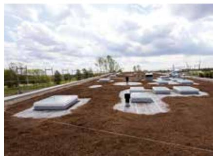
Die fertig eingebaute Systemerde „Steinrosenflur“.
