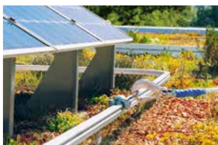
Der horizontal bewegliche Läufer für die persönliche Schutzausrüstung sorgt für maximale Benutzerfreundlichkeit, da sich der Benutzer nur einmal einklinken muss und sich dann entlang der Schiene bewegen kann.
