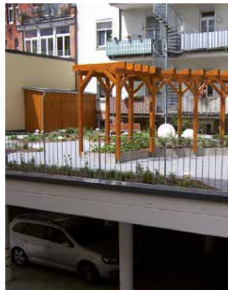
Ob als zusätzliche Rankhilfe oder einfach als Gestaltungselement verwendet, Pergolen lassen sich durchdringungsfrei integrieren. (siehe auch Abb. links unten)
