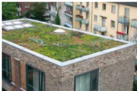
Ein zwar hohes Gebäude, aber umgeben von ähnlich hoher oder höherer Bebauung ist nicht so kritisch zu sehen.
