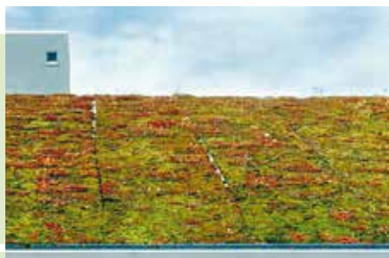
Fugen bei Vegetationsmatten
