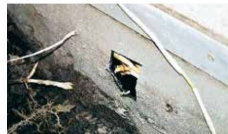
Bereits durch die Abdichtung gewachsene Bambusrhizome
