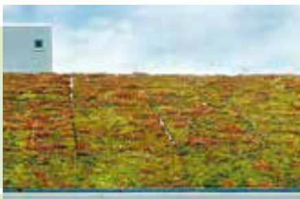
Fugen bei Vegetationsmatten
