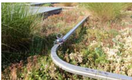
Mit der erforderlichen Auflast kann das Fallnet® SR Rail in Betrieb genommen werden und fügt sich optisch ansprechend in die Dachlandschaft ein.
