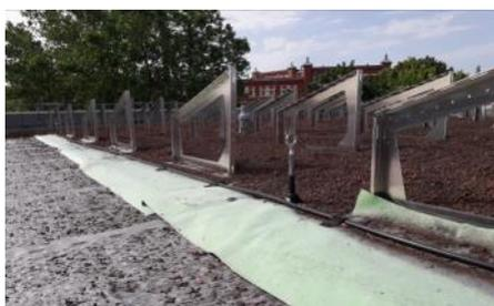
Auf Fixodrain® XD 20 sind die Solarbasisplatten SB 200 mit den Solargrundrahmen platziert. Darüber liegt das Aquafleece® AF 300 (grün) mit seinen Tropfschläuchen.
