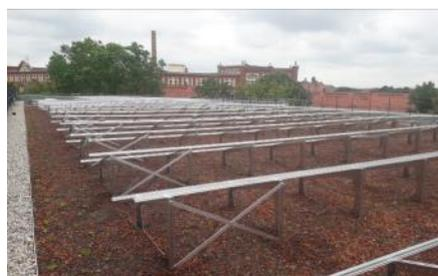
Die Windverbände im Randbereich stabilisieren die Solargrundrahmen. Jetzt ist alles für die Montage der Module bereit.
